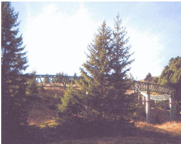
curve con raggi fino a 6 m, dislivelli fino a 50%, montaggio dei binari (scartamento di 1 metro) su prefabbricati di calcestruzzo o ferro, ogni cabina viaggia con il suo motore elettrico ( carica nelle stazioni), mentre frena ricarica le batterie)
